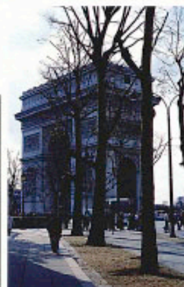
Paris, roída por las termitas Los árboles parisinos están enfermos. El ayuntamiento ha empezado a tratar con hexaflumurón más de mil árboles para evitar el avance de las termitas.
